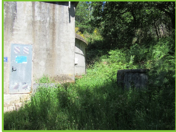
Imagen 7. Pozo con bombas para abastecer el depósito en época de escasez de agua
